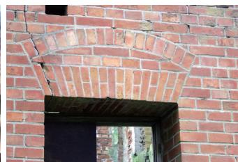
写真2(上)白御影石による基壇装飾。3(左下)西棟デンティル部分。4(右下)隠しアーチと扁平アーチの組み合わせ。
