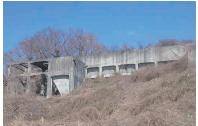
写真1 今も残る茨城無煙炭鉱第三鉱の遺構（茨城県北茨城市）
